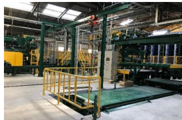
設備入替新設備
