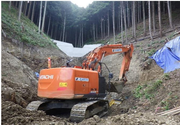
谷止工(復旧治山事業)の様子
