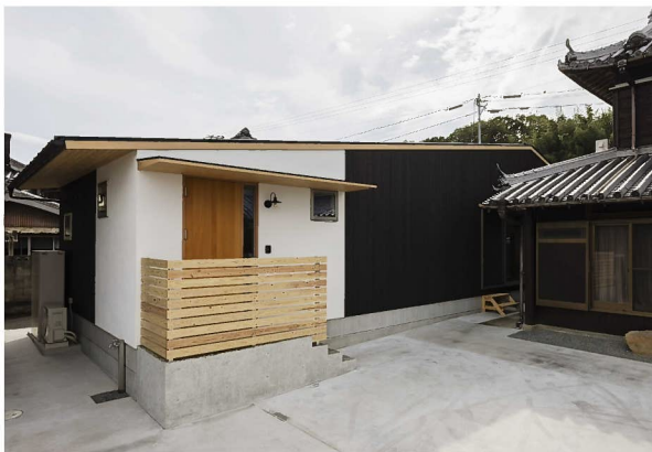
住宅新築(外壁)漆喰と焼杉 (性能)長期優良住宅・高気密高断熱
