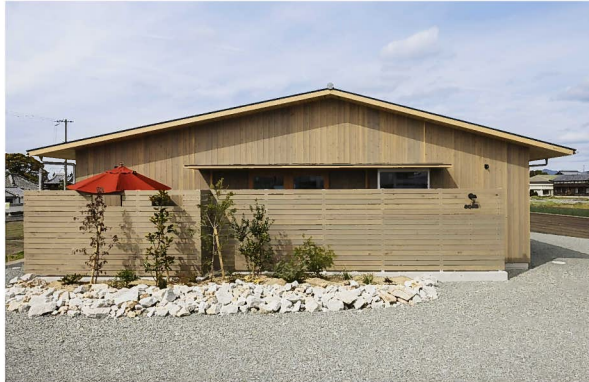
店舗新築(外壁)杉板貼り
