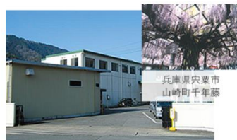
兵庫工場 (各種香辛料・カレー粉・カレールー等製造工場)
