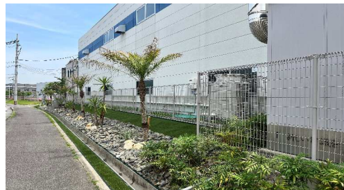
↑会社前外構工事完工後
