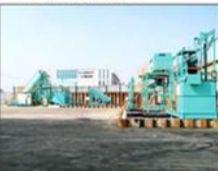
・再資源化施設内全景
