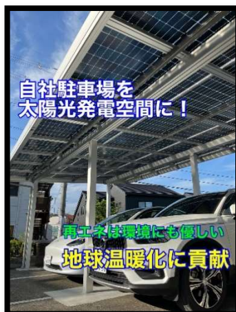
太陽光パネル両面一体型「ソーラーカーポート」を設置
