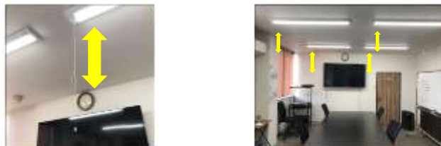
使用する箇所だけ点灯させることで電気量を削減
