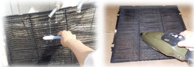
エアコンフィルター清掃
