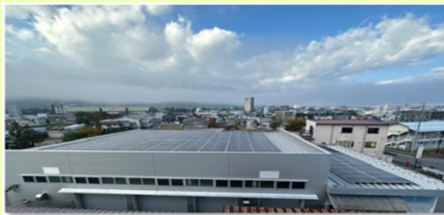
太陽光発電設備
