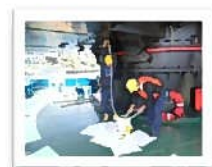
吸着マット敷設
