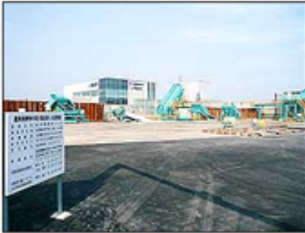
・再資源化施設入口
