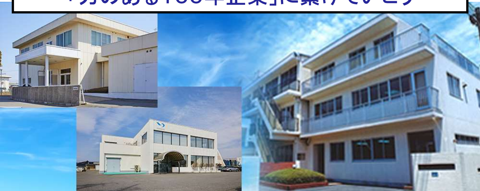
・ハヤシレピック佐貫工場(左上)館山工場(中央)本社(右)
