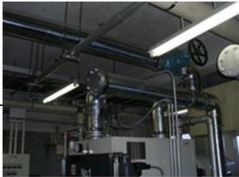
提案2. 蒸気ヘッダー 2. No1ボイラー上部配管
