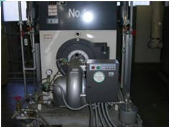
提案3. 蒸気ボイラーNo1運転状況
