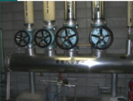
提案2. 蒸気ヘッダー 2. No1ボイラー上部配管
